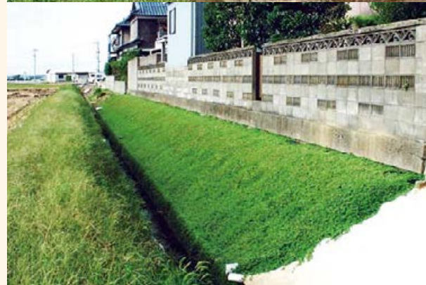
植栽シートに、ヒメイワダレソウの苗を植えた法面(写真上)。施工後、半年から10カ月で緑に覆われる(写真下)
