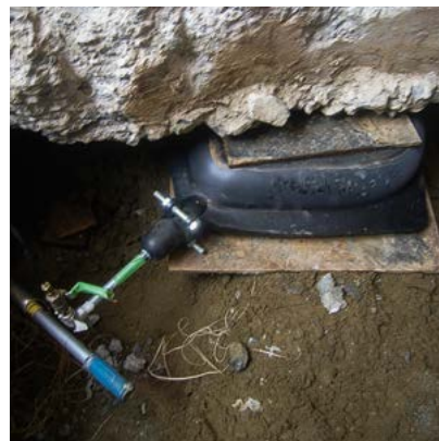
基礎の下に設置され、膨らませたジャケット
