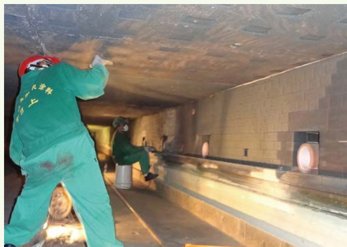
焼成炉内部に断熱塗料を塗布する様子。熱輻射率が20～30%ほどアップする
