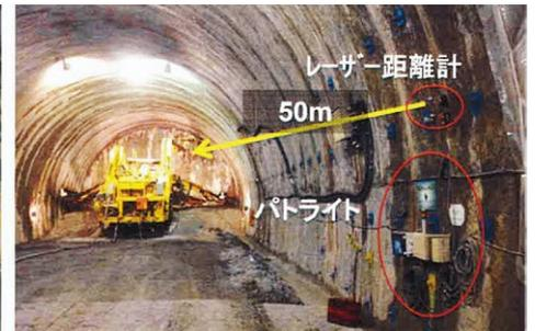
トンネル工事の現場で掘削面に再帰反射性塗料を塗布する様子（写真左）と変位の計測状況。
