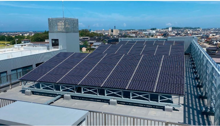
新棟の屋上に設置した 太陽光発電パネル。
