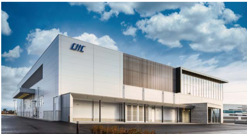
昨年12月、福島産業団地内で竣工した新本社工場の外観。晴れた日には白山を一望できる。
