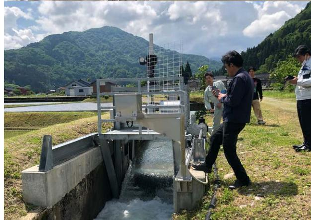
白山市三ツ屋野地区の農業用水に設置したマイクロ水力発電機。
