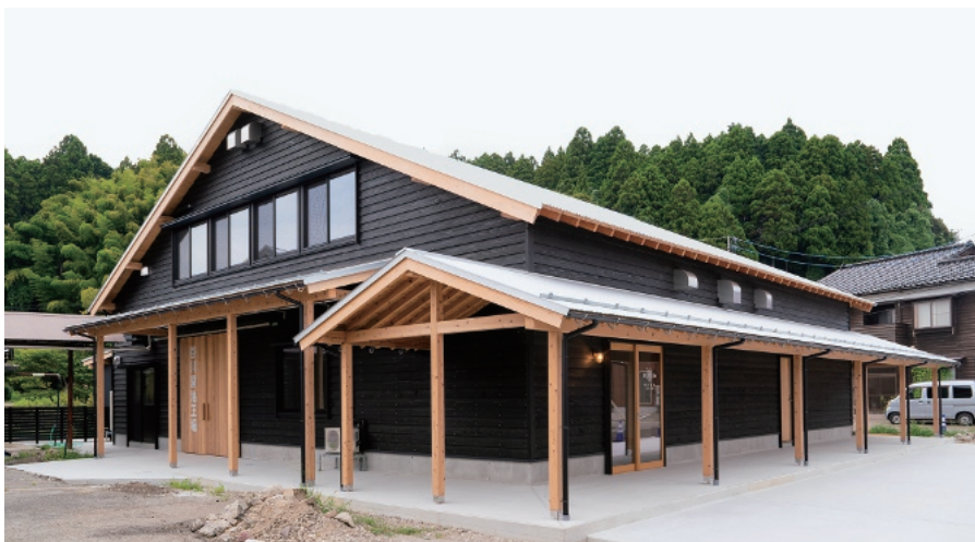
新たなしょうゆ蔵。本醸造しょうゆは年内に仕込みを開始し、2028年に完成する予定だ。
